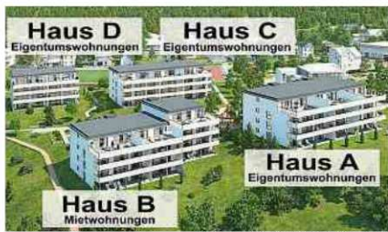
Die «Thurblick»-Wohnungen sollen im Herbst 2015 fertiggestellt sein. Visualisierung: OPM Immobilien & Marketing GmbH
