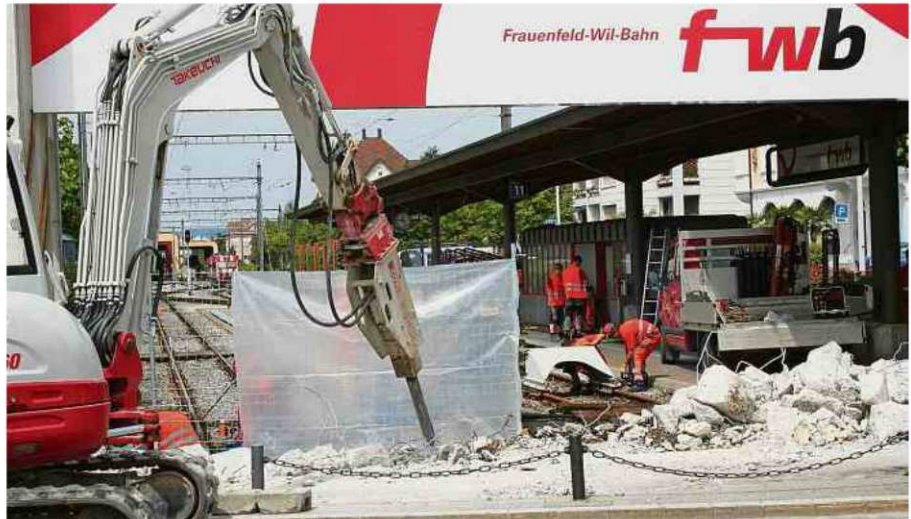
Während der Bauphase steht den Fahrgästen ein Ersatzperron auf der Höhe des Veloständers am Westende des normalen Perrons zur Verfügung.
